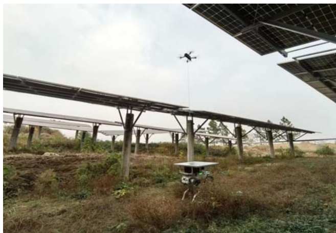
图4 山地光伏实测图
