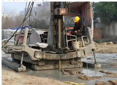
图1 高压喷射设备在指定土层中注入浆液
