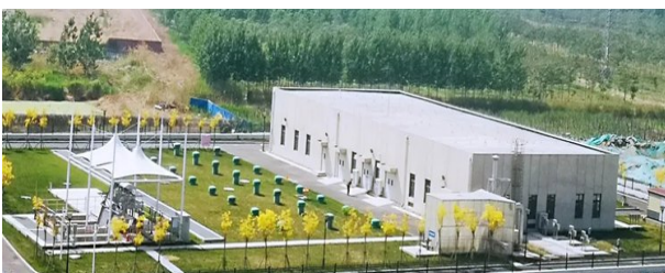
图二 调蓄池建成后实景照片
