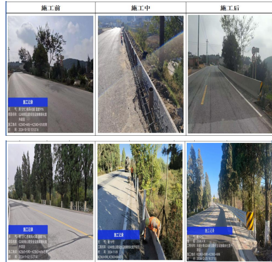
图4 G248线公路安全设施精细化提升项目施工前中后照片
