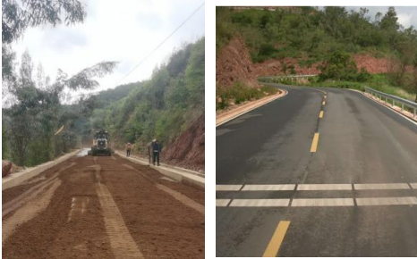
图3 姚直线二期旧路面铣刨利用铺筑级配层, 改建原则利用现有公路, 遵照利用和改建相结合的原则,
