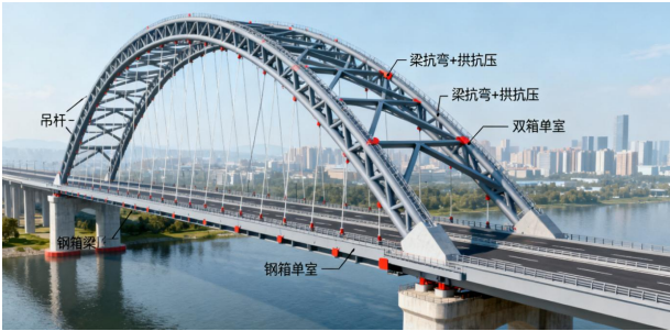
图 1 连续梁拱组合钢结构桥梁结构图
