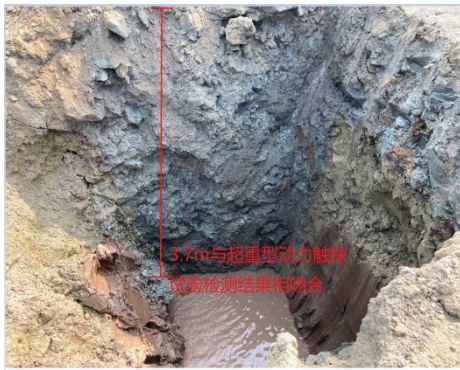
图 4 1#置换墩开挖验证
