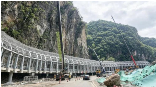
图3 轻型钢棚洞结构示意图
