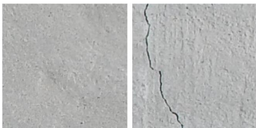
图1 混凝土桥面无裂缝、裂缝图像示例
