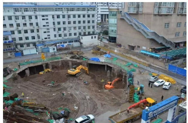
图1 城市复杂环境下深基坑土方开挖施工现场
