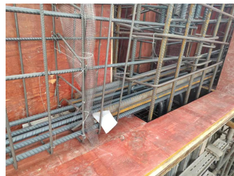
图5 构造柱钢筋预埋现场
