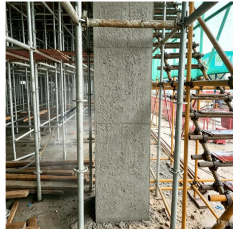
图4 拉毛后构造柱实体
