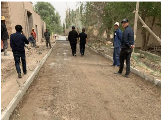
图9 和田农村公路建设项目
