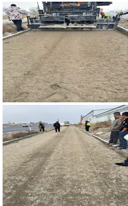
图6 乌鲁木齐市市政道路水稳基层应用
