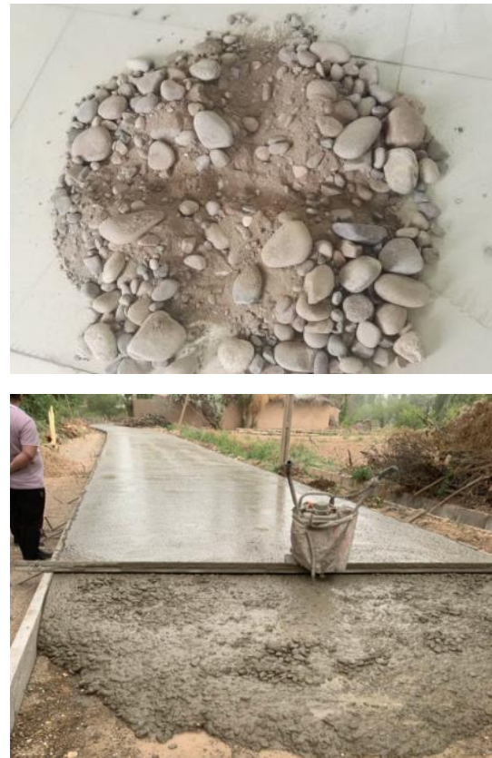
图8 喀什农村公路建设项目
