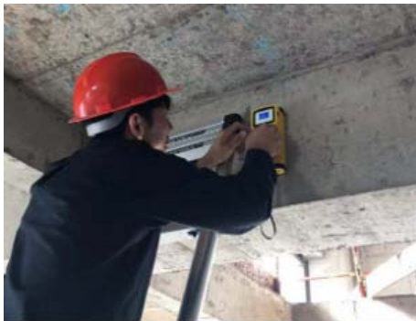
图 混凝土厚度检测
