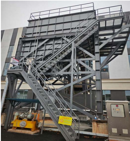
图4 方形斜底污泥料仓
