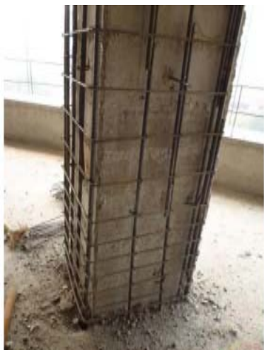
图2 增大截面加固法(框架柱)
