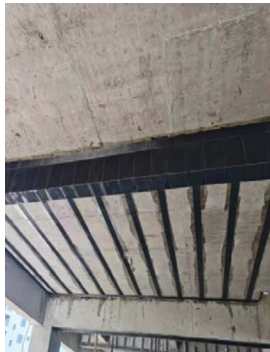
图5 碳纤维布粘贴加固法(框架梁)
