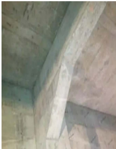
图7 梁端加腋构造加固法(框架梁)
