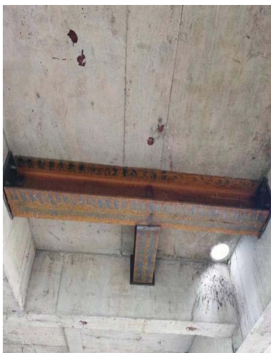
图9 增加钢梁加固法(楼板)
