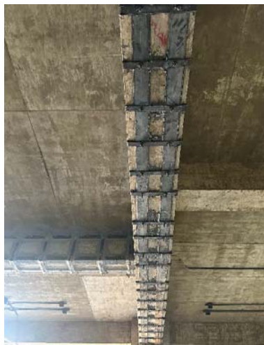
图6 粘贴钢板加固法(框架梁)
