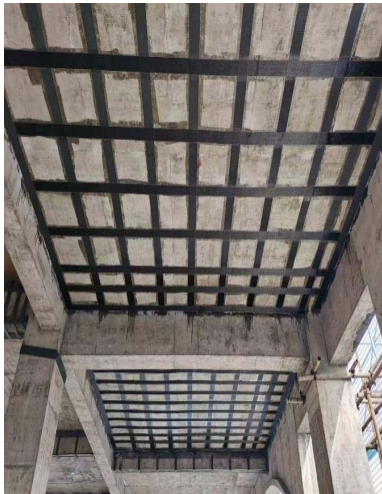
图8 碳纤维布粘贴加固法(楼板)
