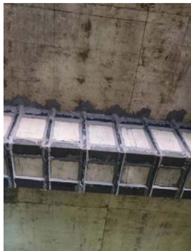
图4 外包钢注胶强化加固法(框架梁)
