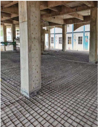
图10 新增钢筋混凝土楼板加固法(楼板)
