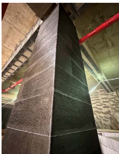
图3 粘贴碳纤维布加固法(框架柱)
