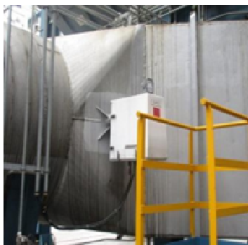
图2 焦化装置F02加热炉CO分析仪
