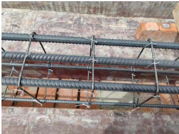
图1 钢筋绑扎胎具施工示意
