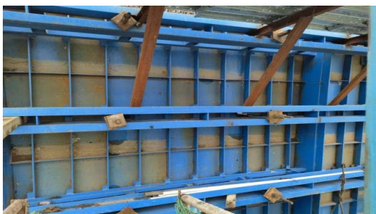
图4 主塔模板加固
