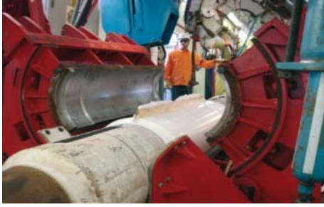
图1 EUPEC international补口业务部典型施工图片
