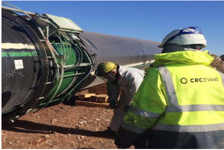
图1 EUPEC international补口业务部典型施工图片
