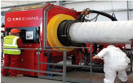
图2 PIH补口公司典型施工图片
