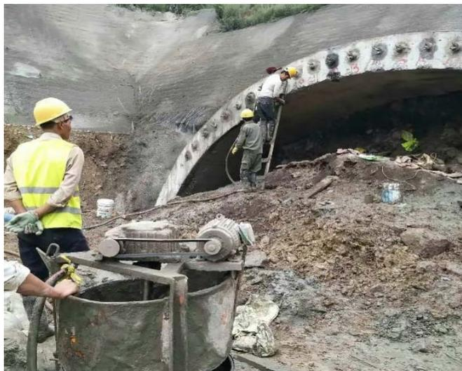
图1 隧道管棚注浆现场图
