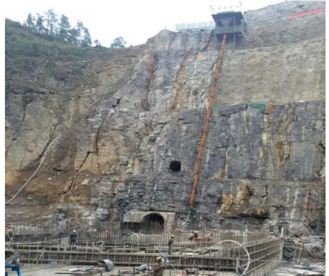
图2 溜管垂直运输系统安装示意图
