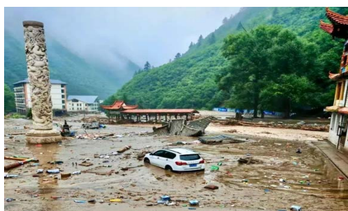
图2 山洪过后的兴隆山风景区
