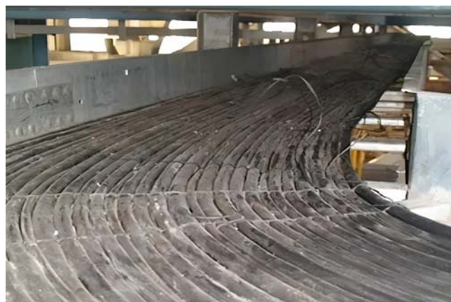
图1 电缆在桥架内的敷设示意图
