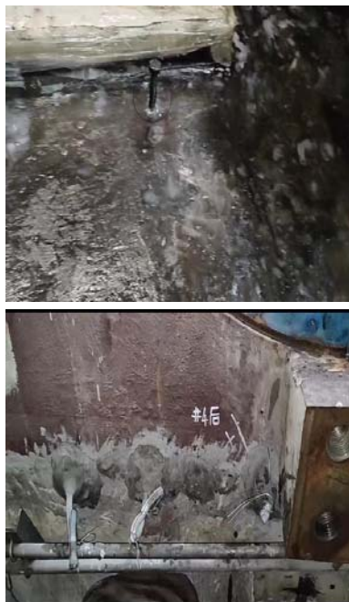
图二轴承座台板与基础注胶孔和出胶孔
