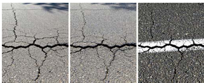
(a)原始图像 (b)自适应中值滤波后 (c)直方图均衡化后 图1 预处理前后的裂缝图像对比
