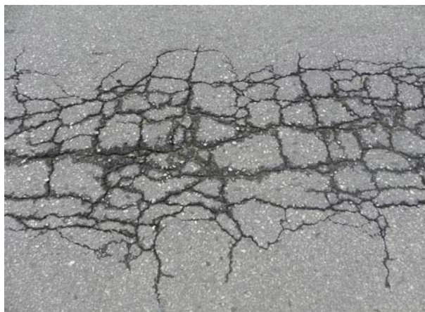
图1 网状裂缝
