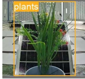
图5 杂草遮挡光伏板
