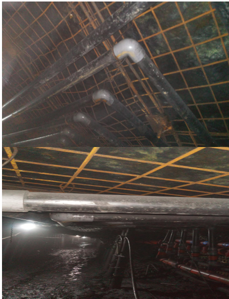
抽采系统优化顶部管路布置图
