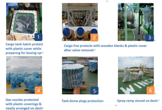
图5 现场拆除后的保护
