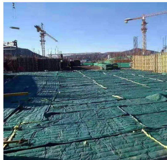
图1 混凝土养护保温措施实景图
