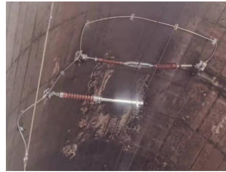
图 16 隧道内水平悬挂整治
