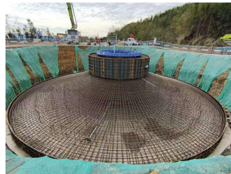
图5 基础钢筋及模板安装
