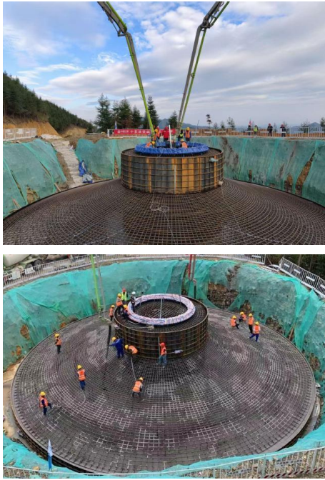
图6 基础混凝土分区浇筑
