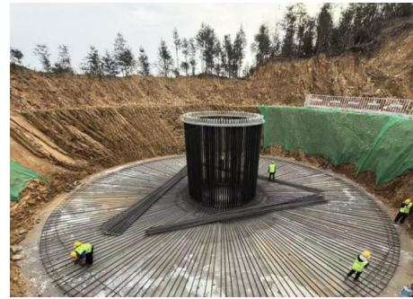
图4 锚栓笼安装示意图
