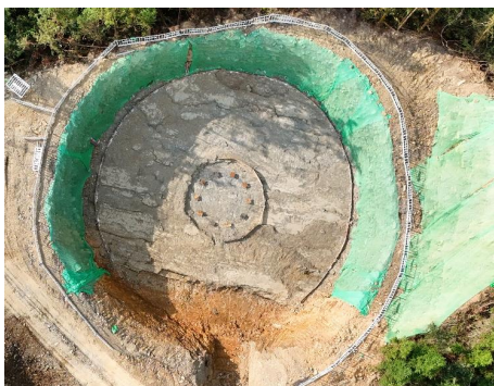
图2 风机基坑开挖示意图
