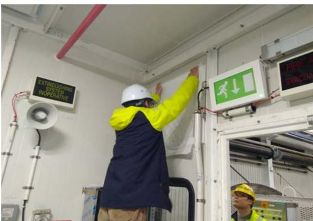
图6气密测试时, 电气房的气密百叶窗使用胶带临时封堵
