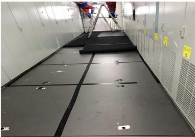
图5气密测试时, 电气房地板上检修孔洞处使用临时胶带封堵
