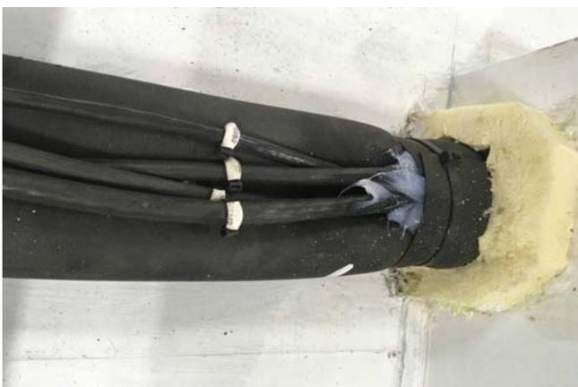
图2 电气房电气管穿越顶板发泡剂封堵
