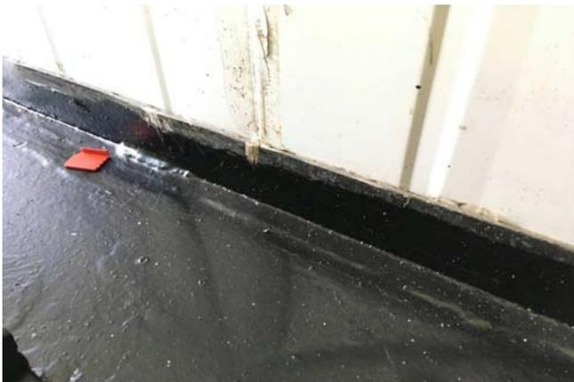
图1 电气房围棚板接缝处涂透明聚氨酯密封胶
