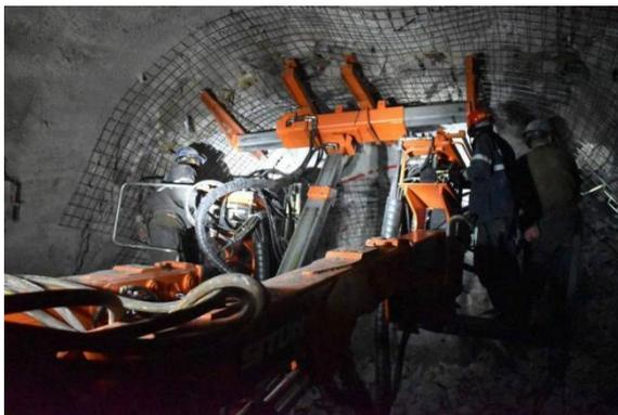
图1 煤矿用双臂液压锚杆钻车矿用巷道支护设备
