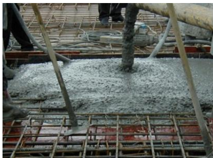
图2 混凝土浇筑
