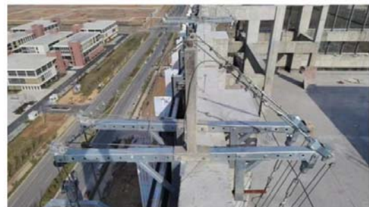
图 2 骑墙式悬挂机构组装
