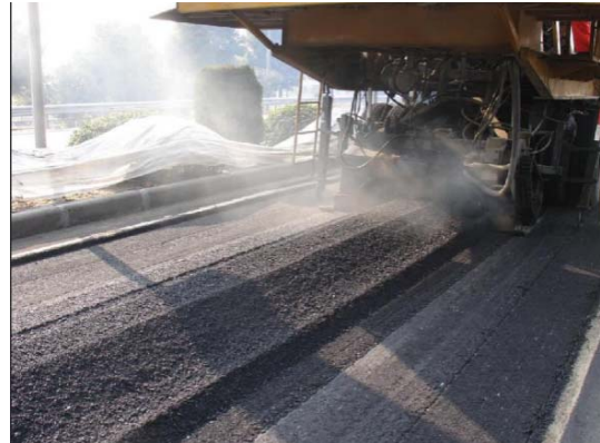
图 道路工程就地热再生技术应用施工现场
