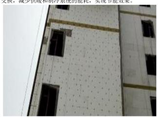
图 1 外墙保温聚苯板
