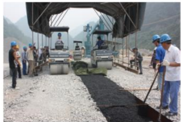
图2 沥青混凝土浇筑
