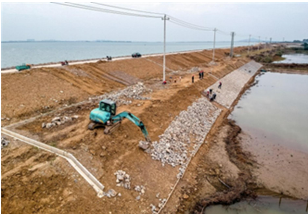
图1 水利工程堤防护岸工程施工现场
