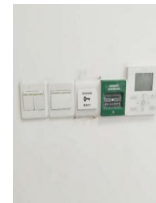
控制网面板安装
