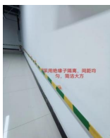
接地扁铁绝缘子隔离
