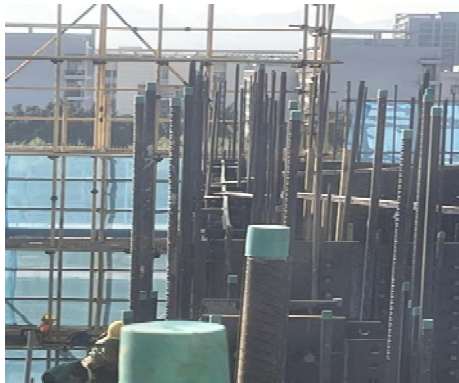
图5.3-1 活动后钢板墙施工效果
