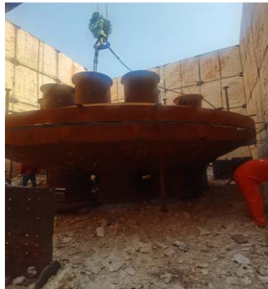
图3 上管箱整体热处理
