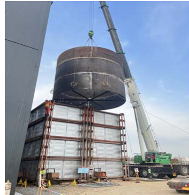
图2 壳程筒体吊装进炉
