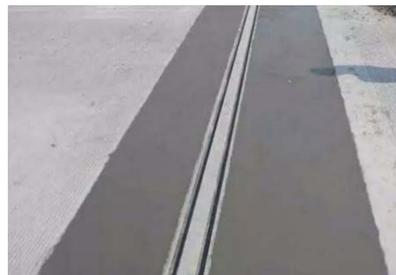
图3 伸缩缝修复效果
