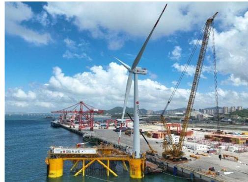
图2 漂浮式风机安装
