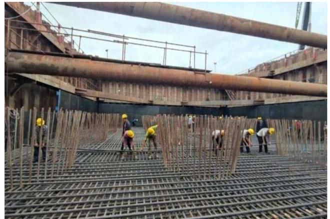
图2 承台钢筋安装
