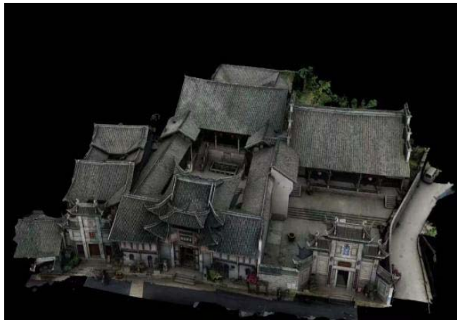
图6 徽派古建筑无人机数据采集(自绘)
