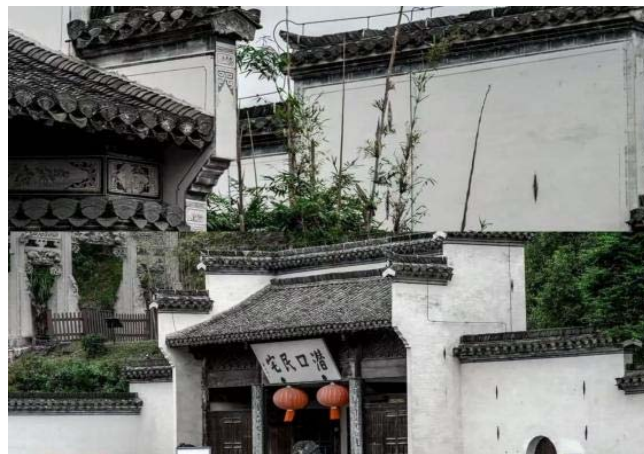
图4 查济徽派建筑修缮完成图(自摄)
