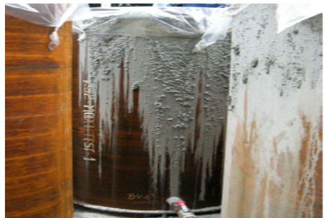
图5 现场压力表和灌浆现场
