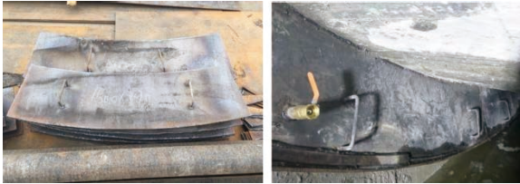
图4 弧形钢板及止水箱体
