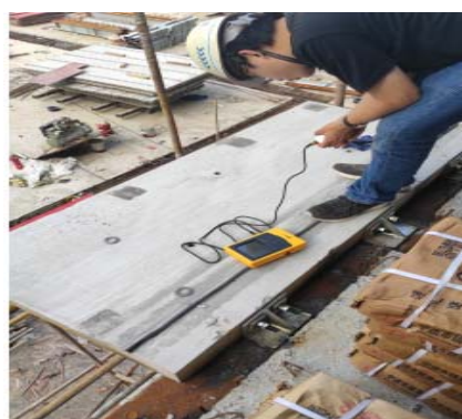
(9) 检测挠度、裂缝等参数
