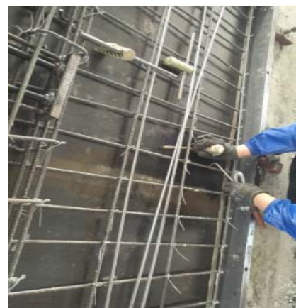
(2) 安放钢筋绑扎
