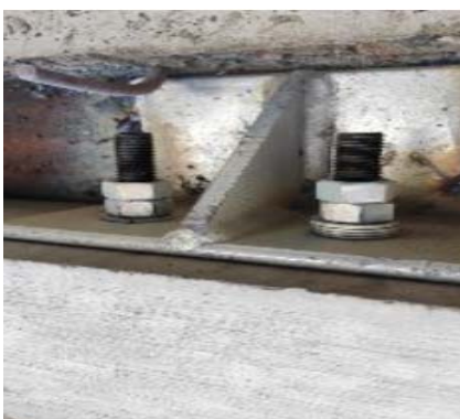
(7) 检查焊接质量
